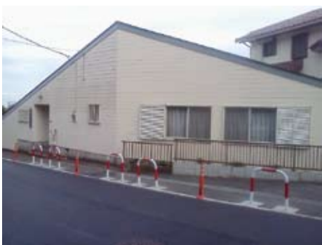
千代ヶ丘中ノ間自治会館
