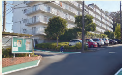
サニーハウス外観
