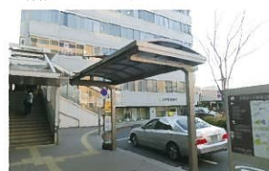
新百合ヶ丘駅北口ロータリーのタクシー乗車場に設置された屋根
